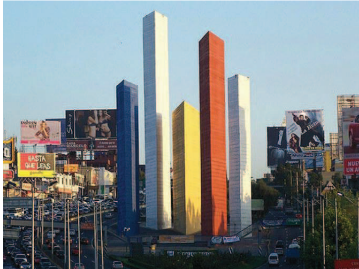
Imagen 99: Mathias Goeritz, Luis Barragán, Jesús Reyes: Torres de Satélite , 1957-58 Cinco prismas de hormigón armado policromado de entre 30 a 52 metros, Ciudad Satélite, México Fuente: Literal Magazine
