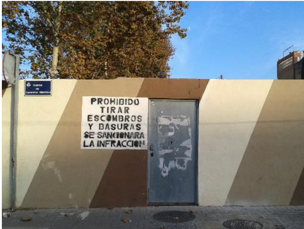
Figura 8. Durante más de dos décadas, el anterior equipo de gobierno del consistorio valenciano destruyó sistemáticamente el entramado urbano del barrio marítimo del Cabanyal. Las franjas diagonales marcaban los solares de antiguos edificios, hoy derruidos.
