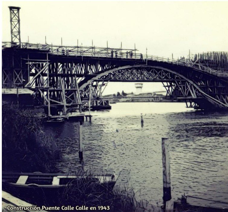
Construcción Puente Calle Calle en 1943
