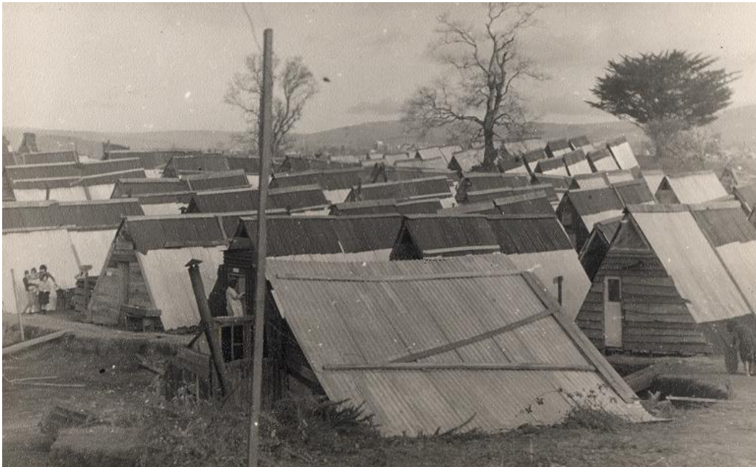
Imagen 13: Rucos en Valdivia con posterioridad al terremoto (1960).
