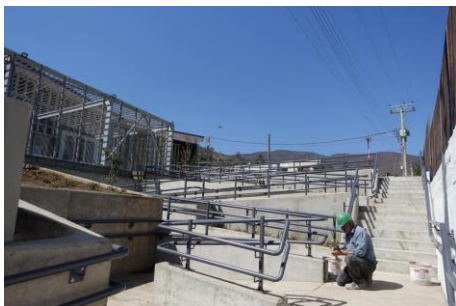
RECUPERACION PASAJE URIBE
