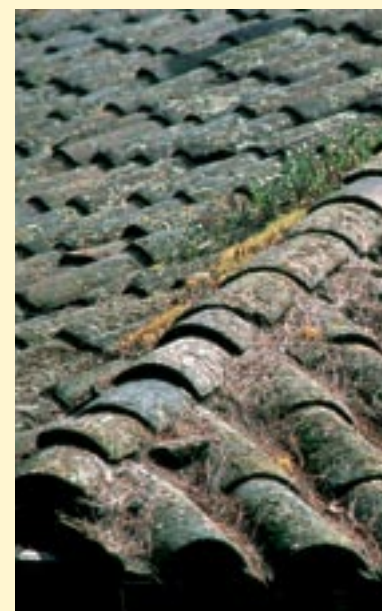
Tejas de arcilla características de la arquitectura tradicional en Chile central.
