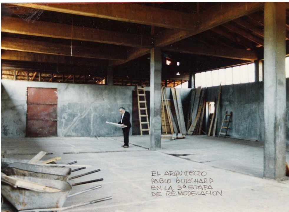
14. Fotografía 3.14. El arquitecto Pablo Burchard Aguayo revisando planos durante la tercera etapa de remodelación del edificio que daría origen al Museo de La Ligua. Archivo histórico del Museo de La Ligua.
