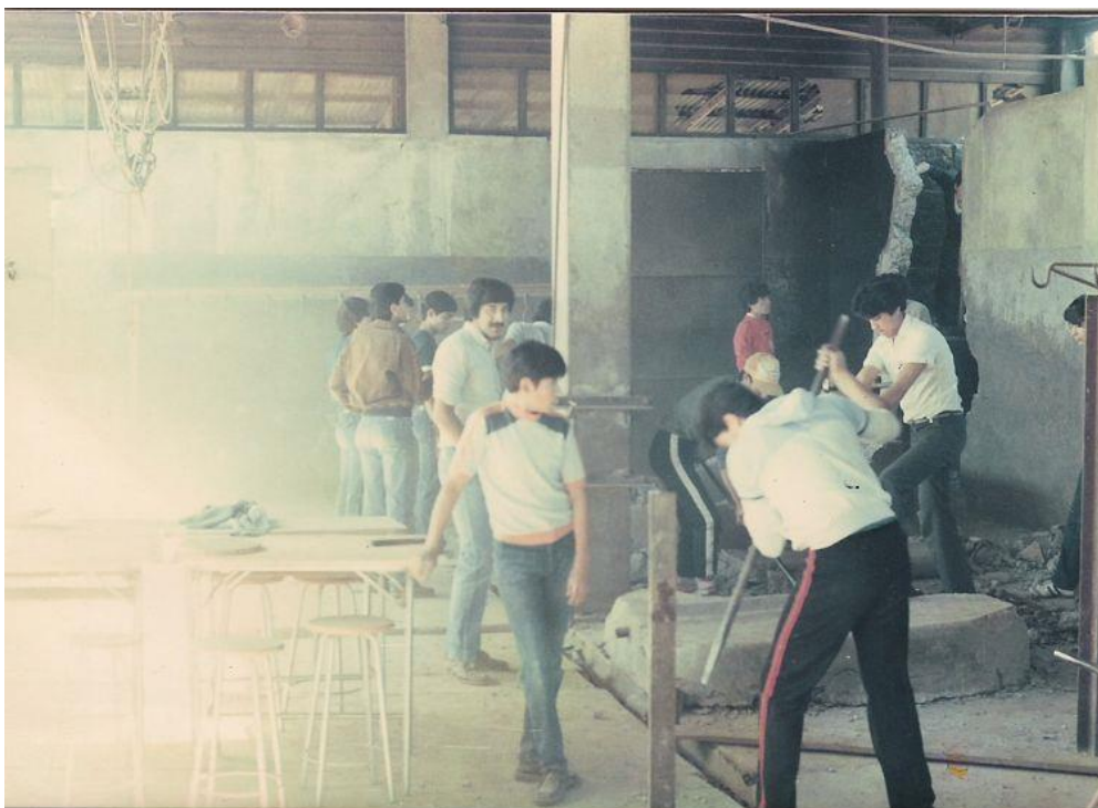
13. Fotografía 3.13. Jóvenes de la Academia Yacas trabajando en la remodelación del antiguo matadero municipal para convertirlo en el Museo de La Ligua. 1984–1985. Archivo Fotográfico Museo de La Ligua.
