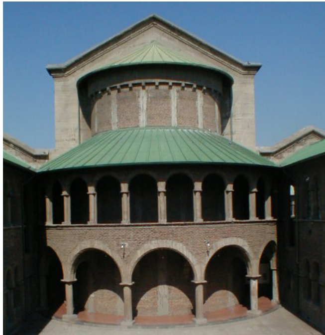
Lámina V: Fachada trasera de la capilla de Campus Oriente.
